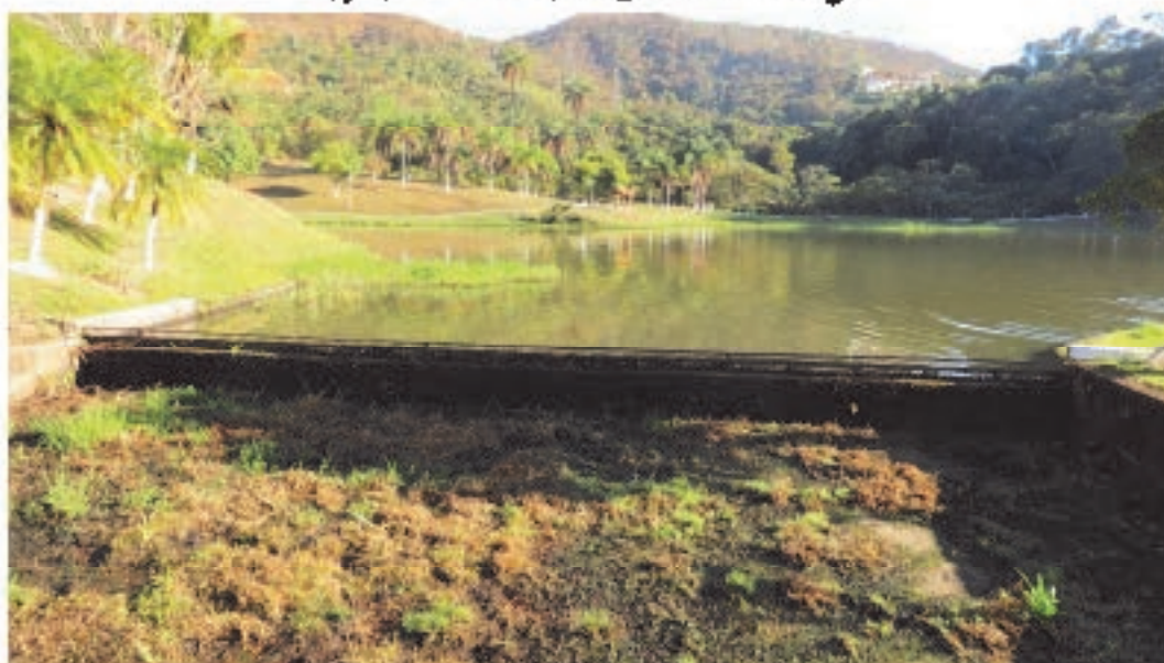
Foto 2 - vertedouro do reservatório com baixo escoamento da água. Aspecto da análise - Qualidade da água
